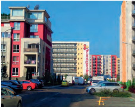
Abb.II.7.5 Neue Eigentumswohnungen am Stadtrand von Braşov/Kronstadt
